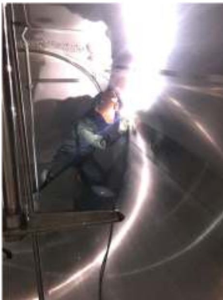
溶接風景（バルク内部）
