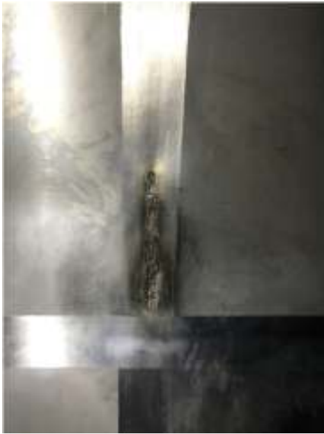
ひび割れ部分溶接、研磨後
